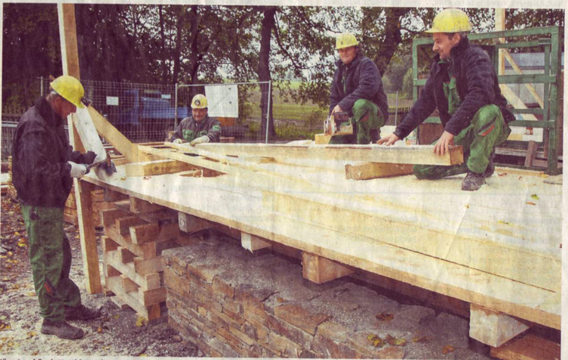
Jörg Junghänel, Matthias Kehr, Lars Pohlheim und Jens Rasl (v. l.) von der Bergsicherung Sachsen errichten die Bühne für die Fördereinrichtung. Wenn die Vorrichtung fertig ist, soll der Vater-Abraham-Schacht für die Fachleute befahrbar sein.
